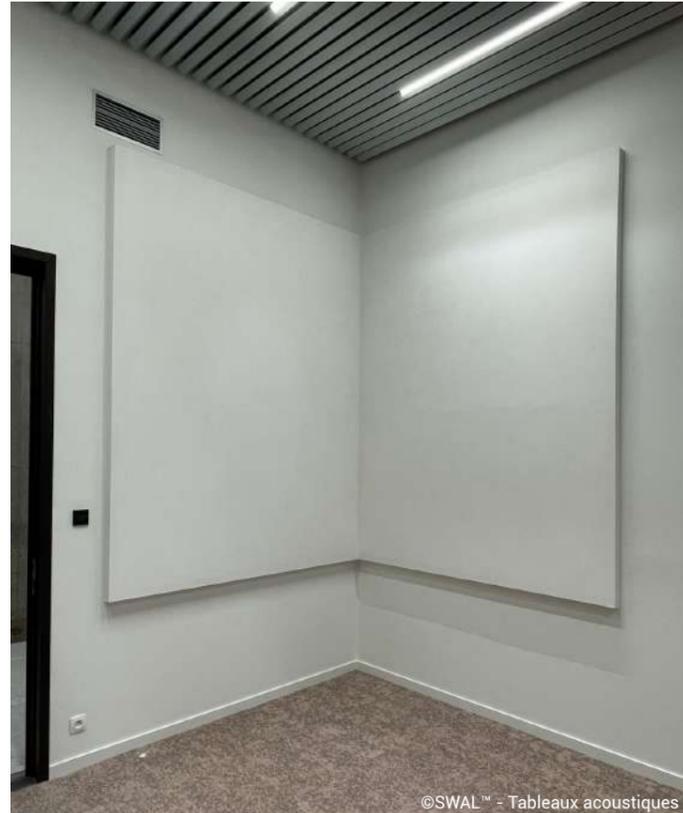
Chaque cadre est réalisé sur mesure, avec un profilé aluminium rigide et discret, dans lequel vient se tendre une toile acoustique imprimée ou unie.
